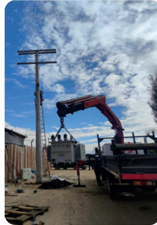
Realizamos todo tipo de instalación y mantenimiento en la red de media y baja tensión, incado de postes construcción de línea instalación de transformadores, tramites y legalizaciones ante las electrificadoras.
